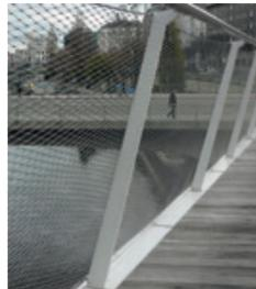
Siebdruck ist haltbarer als Folien und kann auch außen (Ebene 1) angebracht werden.
