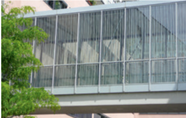
Verbindungsgang mit transparenten Vogelschutzstreifen
